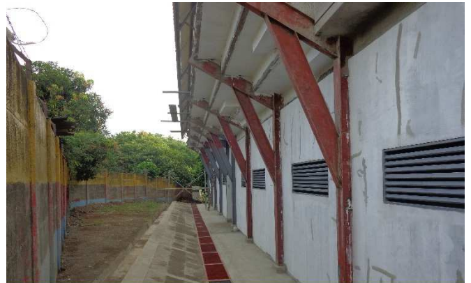
Se observa la fachada oeste de la gradería y obras de mitigación de la edificación
