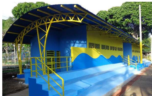
Fachada principal del edificio de vestidores de Voleibol de Playa, donde se observa la gradería para
