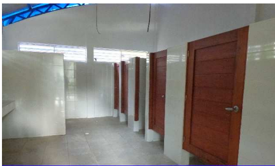
Vista interna de la batería sanitaria de mujeres en el edificio de servicios sanitarios; apreciar la ejecución de las etapas de enchape de azulejos en paredes
