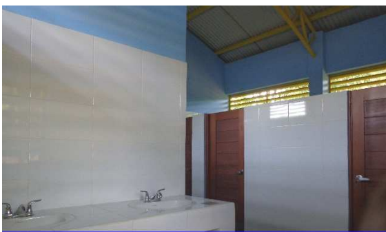
Vista interna de la batería sanitaria de mujeres, con proyecto.
