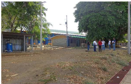
Vista panorámica del sitio donde se construyó el edificio de vestidores de Voleibol de Playa.
