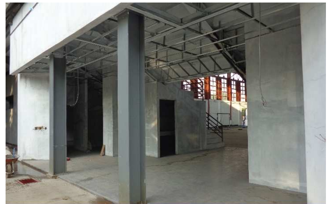
Vista interna del Acceso principal de la Gradería Este, donde se aprecia la ejecución de las etapas de piso, cielo falso.
