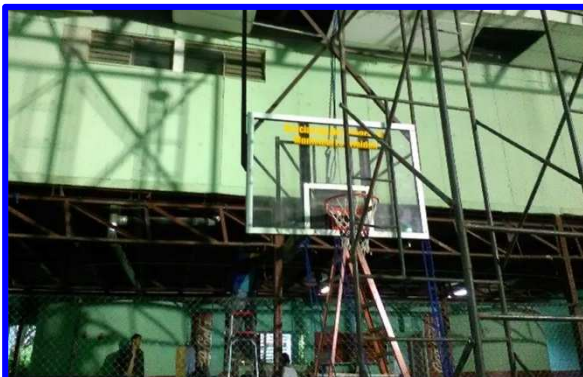
Reubicación de Tableros de Baloncesto.
